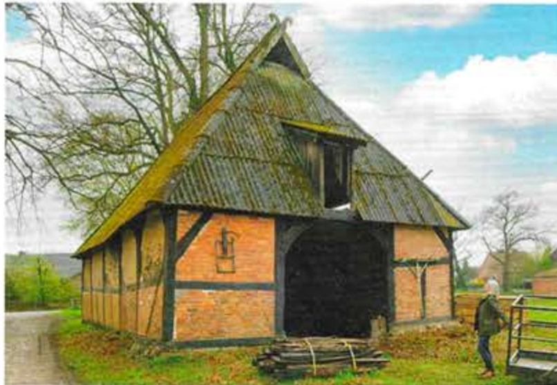
Es war einmal: Inzwischen sind die Eternit-Dachplatten entfernt worden
